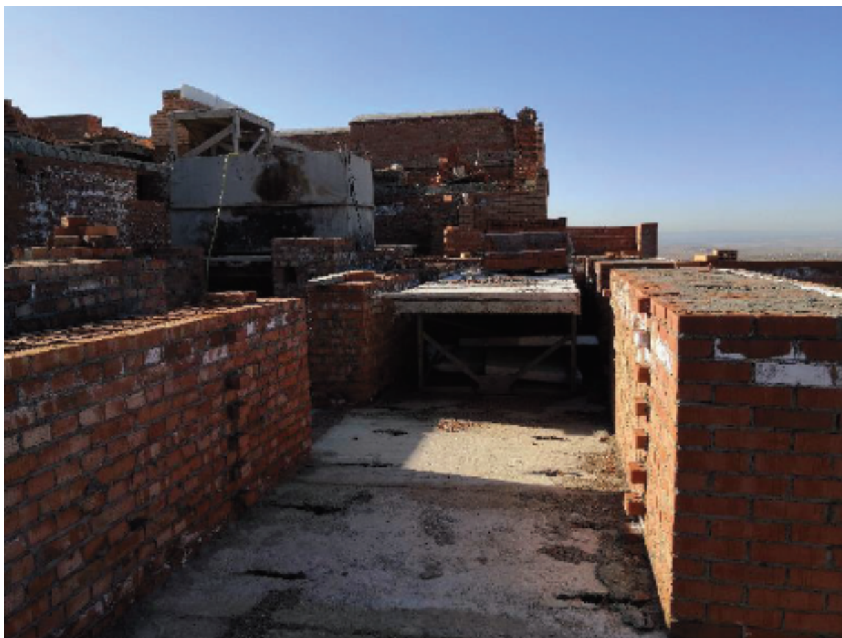
Техническое состояние этажа 17 дома 2–1
