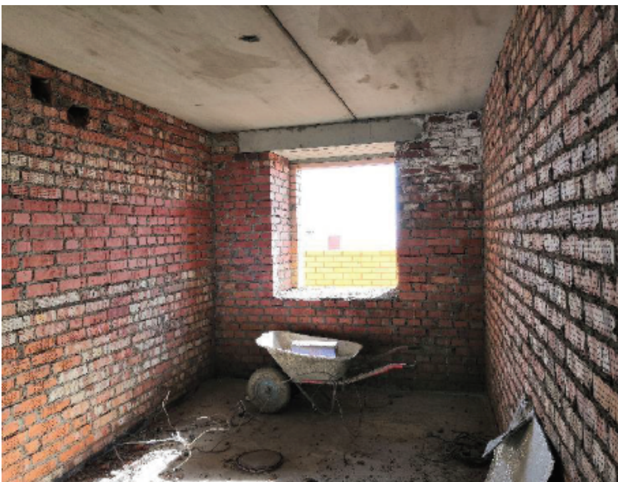
Техническое состояние этажа 16 дома 2-1
